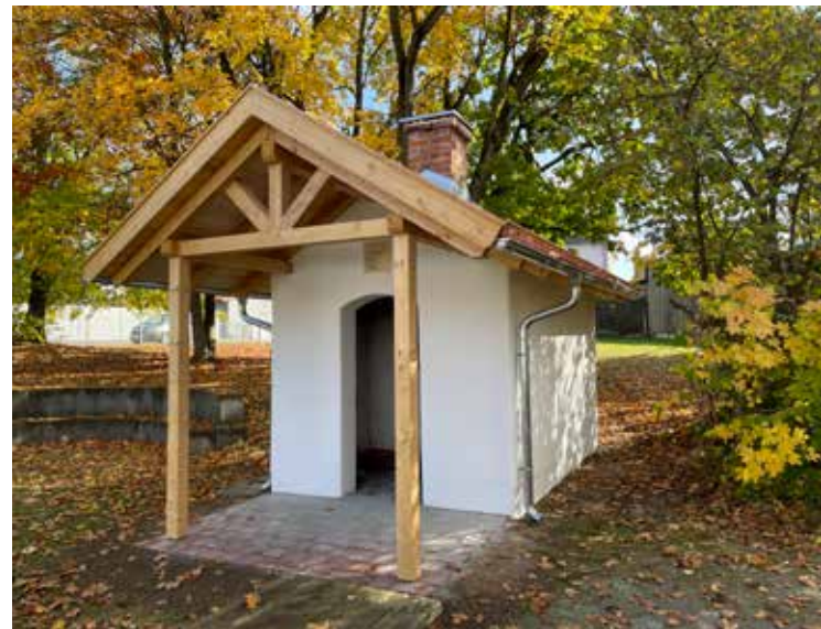
Der OGV Geiselhöring konnte 2023 dank des Fördergelds ein Vordach für den bestehenden Steinbackofen im Schulgarten bauen.
